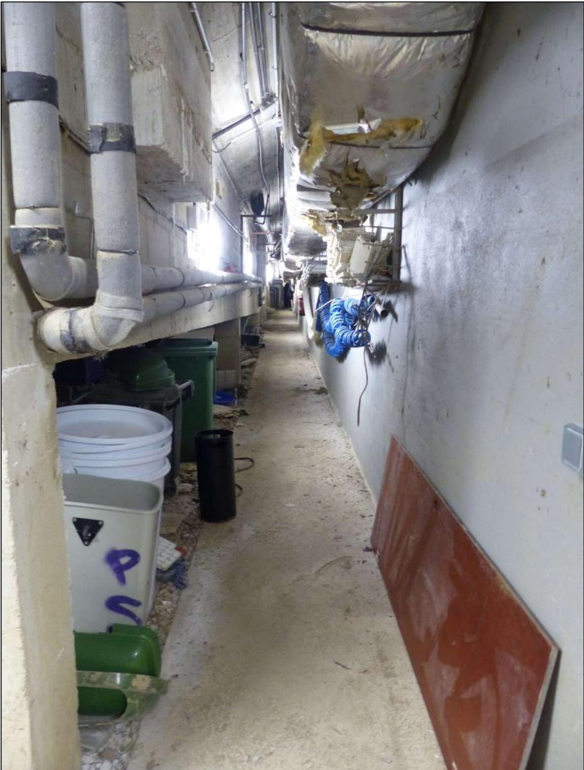
**Figura 53.** Fotografías tomadas en las galerías situadas bajo la piscina municipal cubierta de la localidad. En las mismas se observa la ubicación – en muchos casos en alturas elevadas – de los diferentes sistemas de limpieza y desinfección de la propia piscina, así como de la distribución de los sistemas de bombeo y otra maquinaria almacenada en estas galerías.
