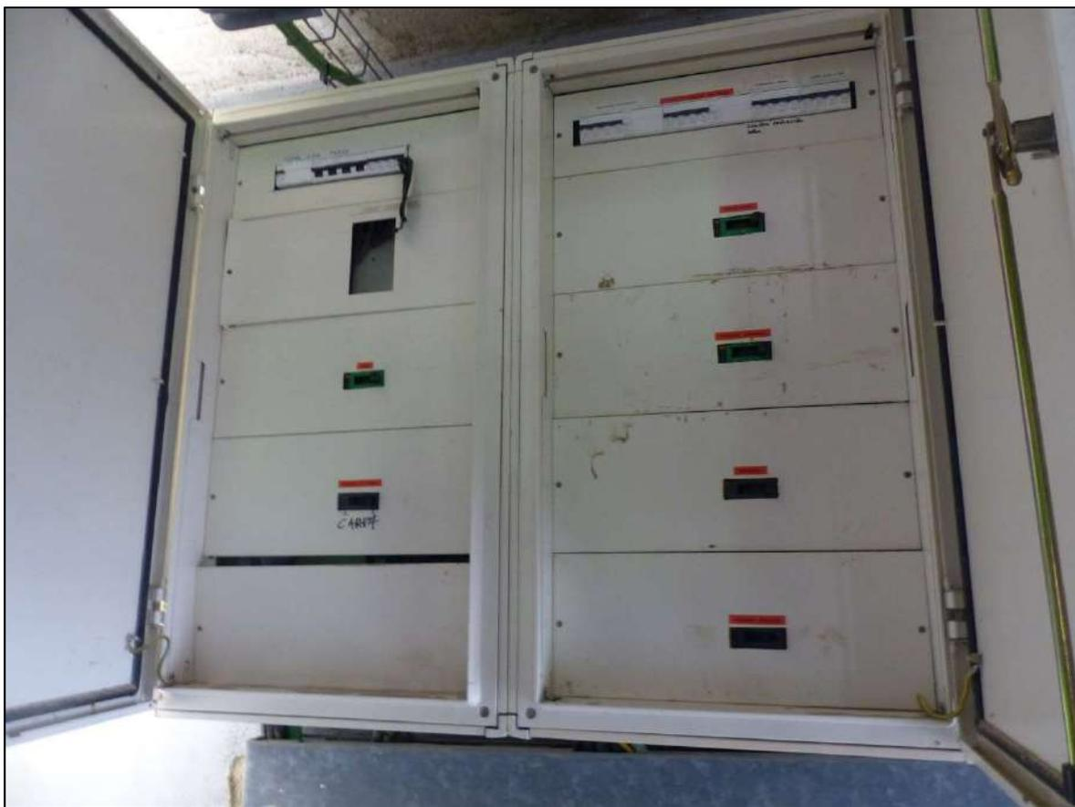
**Figura 56.** Cuadros eléctricos – situados en altura – desde donde deben ser cortados los circuitos eléctricos de las diferentes zonas de las instalaciones en caso de previsión de inundación.
