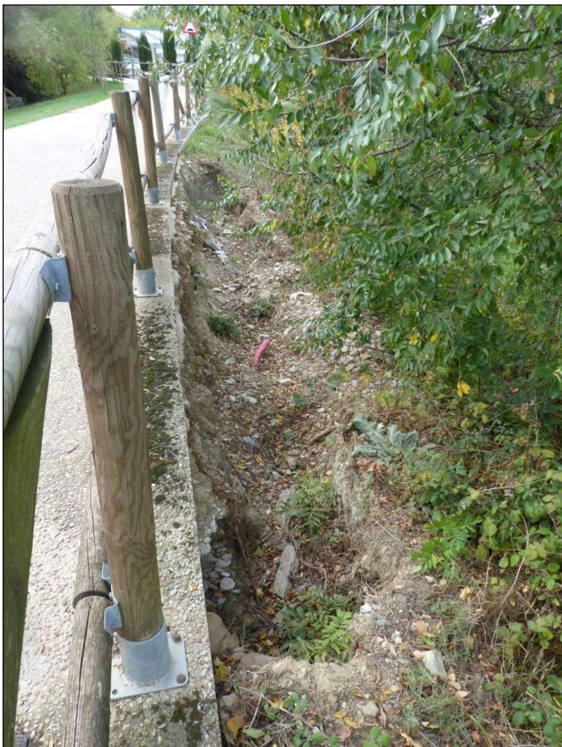
**Figura 65.** Imagen de los daños y roturas causados en la mota y en el paseo peatonal del Arga por los desbordamientos por coronación ocurridos en Burlada en diciembre de 2021.
